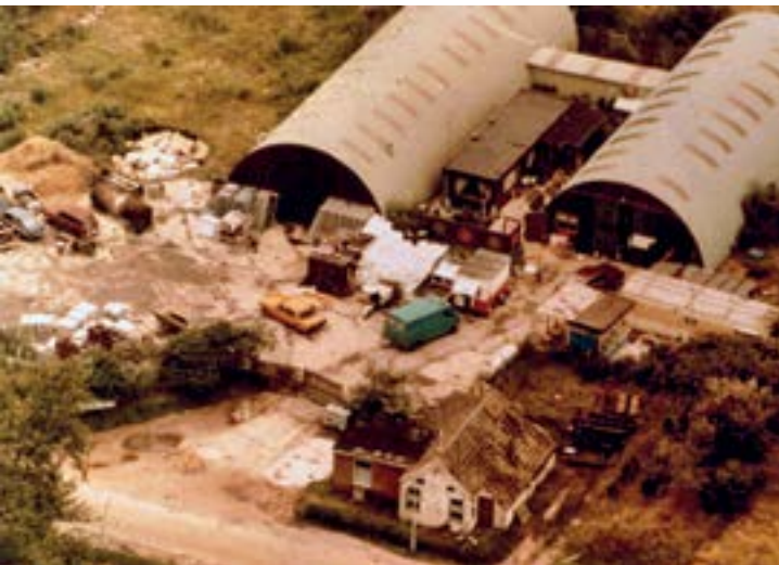
Bouw van de nieuwe loodsen
